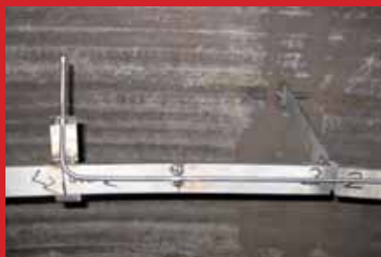
Выполнение разводки сенсора с использованием зажимов под приварку
