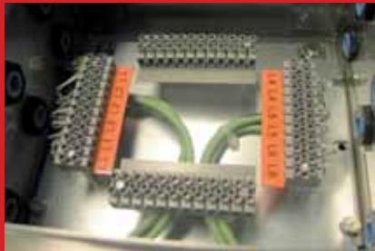
Клеммные блоки термопар с индивидуальной маркировкой
